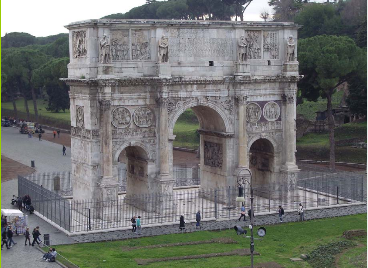
Arco di Costantino
